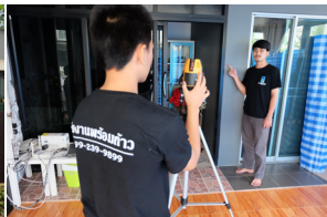
2. ตรวจสอบระดับก่อนทำงาน
