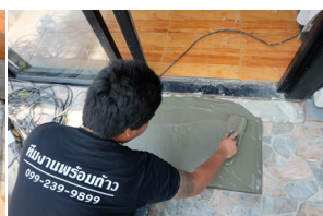
8. ทำการเทคอนกรีตปิดหน้างาน
