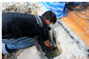
4. ติดตั้งบารับน้ำหนัก
