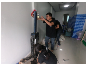
5. ติดตั้งเครื่องกดไฮดรอลิก
