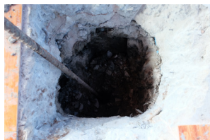
3. ขุดหลุมเปิดหน้างาน 0.8 x 0.8 เมตร
